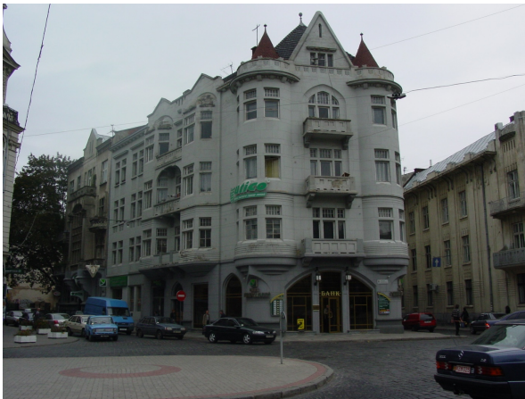
Fot. Lwów. Budynek na Akademickiej, w którym przez II wojnę mieściła się słynna Kawiarnia Szkocka. Wrzesień 2003
